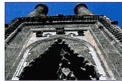
La medrese de Sivas es un arquetipo de arquitectura selyúcida.
