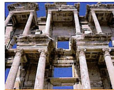
Vista oblicua de la Biblioteca de Celso.
