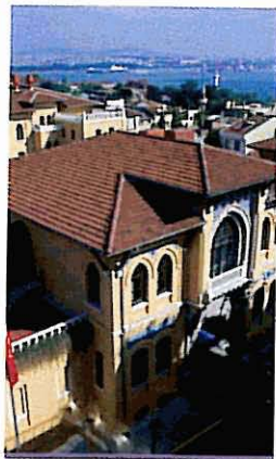
Fachada de un hotel en Sultanahmet.
