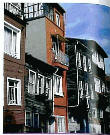
Arquitectura tradicional en Sultanahmet.
