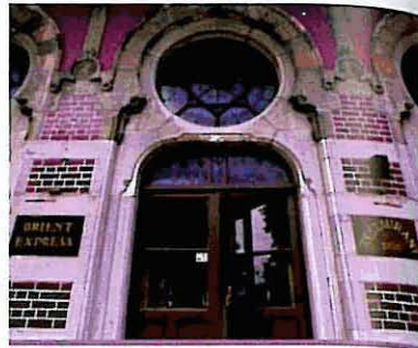
La estación de Sirkeci fue construida sobre la base de los parámetros del neoclasicismo.
